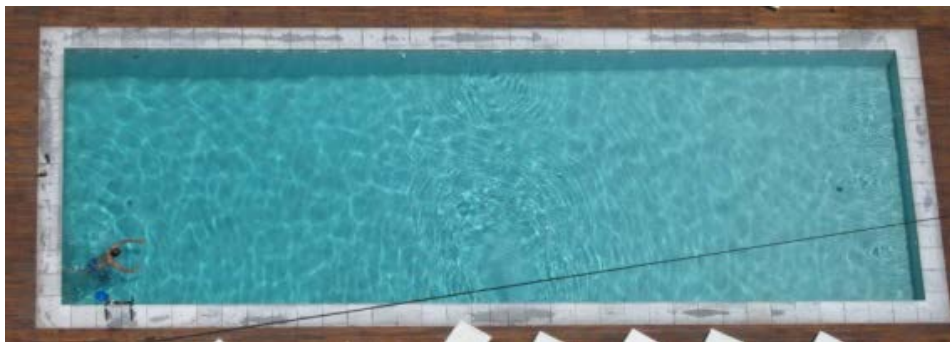
Fig. 5.12 –a) Foto pileta de natación
